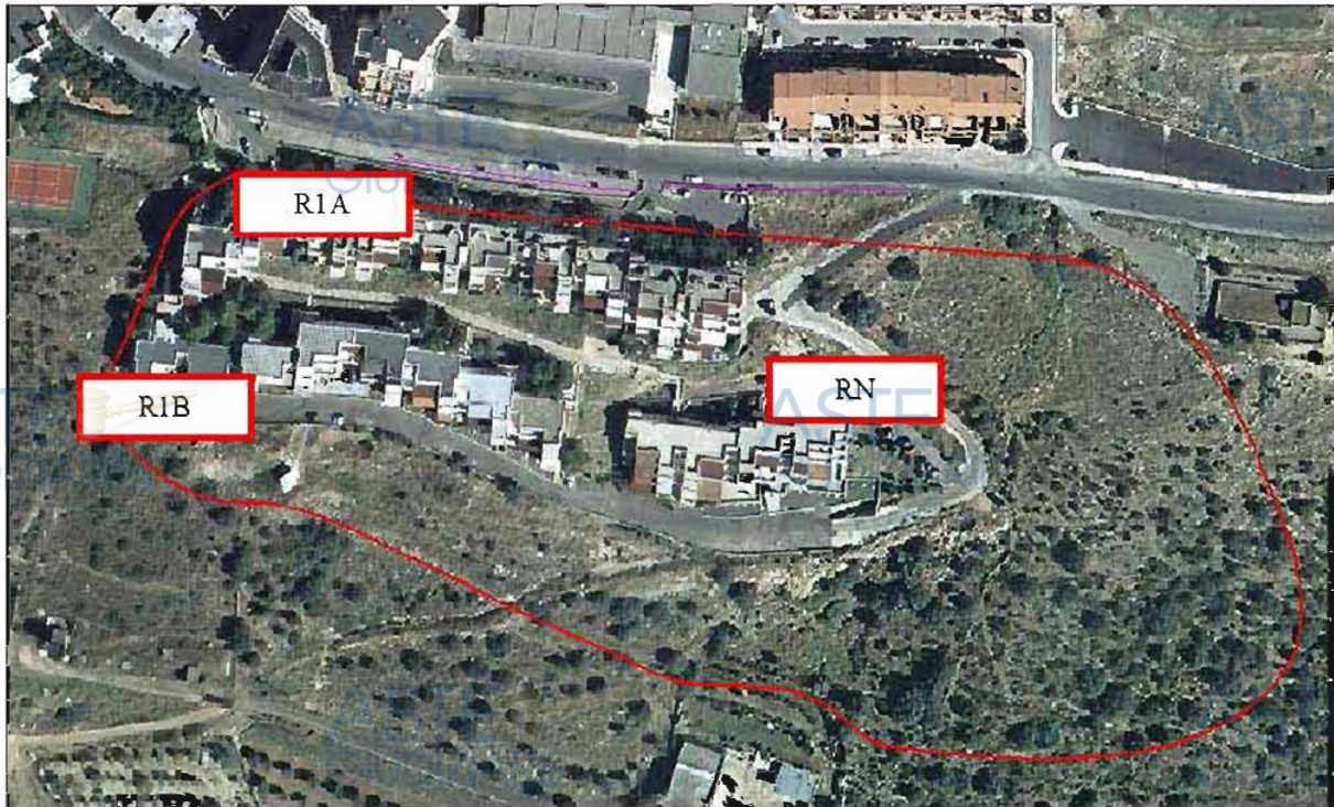
Vista aerea estratta da Google con indicazione della perimetrazione del Comparto C.2.4 e degli edifici R1A, R1B e RN realizzati
