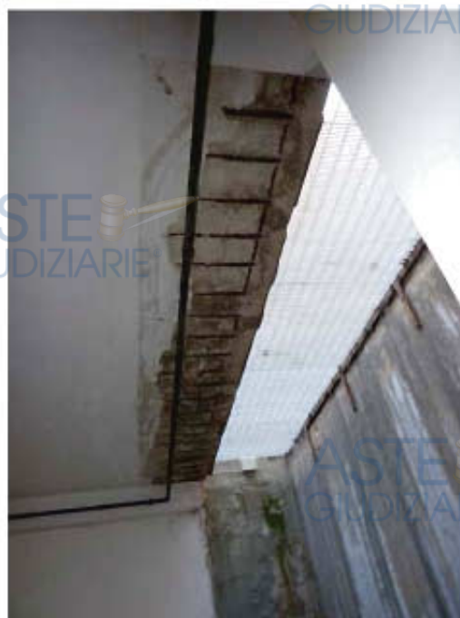
Foto n.3 (vista da piano interrato)
