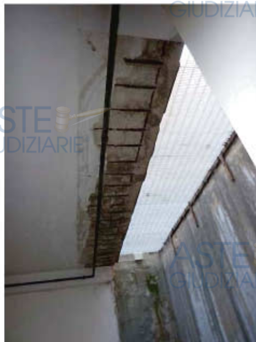
Foto n.3 (vista da piano interrato)
