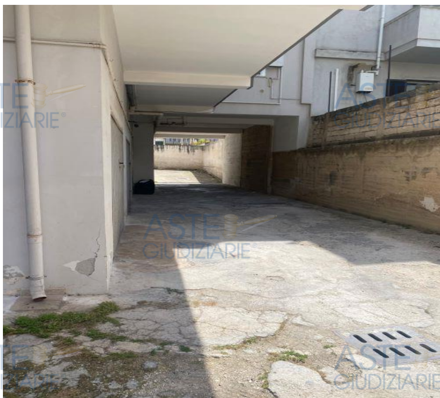
RAMPA DI ACCESSO AL BOX
