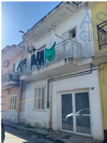
Ingresso garage su via Sillecchia
