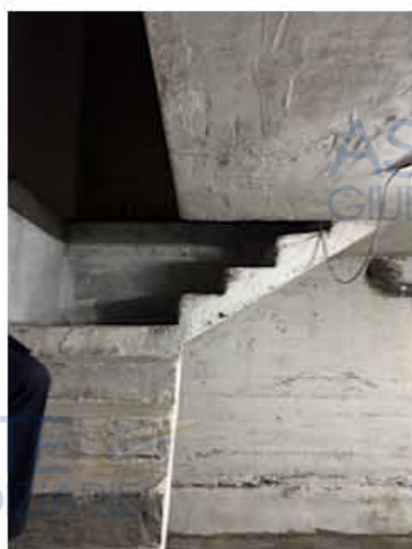
Scala accesso cantina
