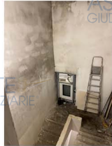
dettaglio pareti vano scala
