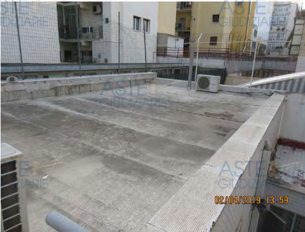
Foto n.77 Impermeabilizzazione della copertura dell'immobile
