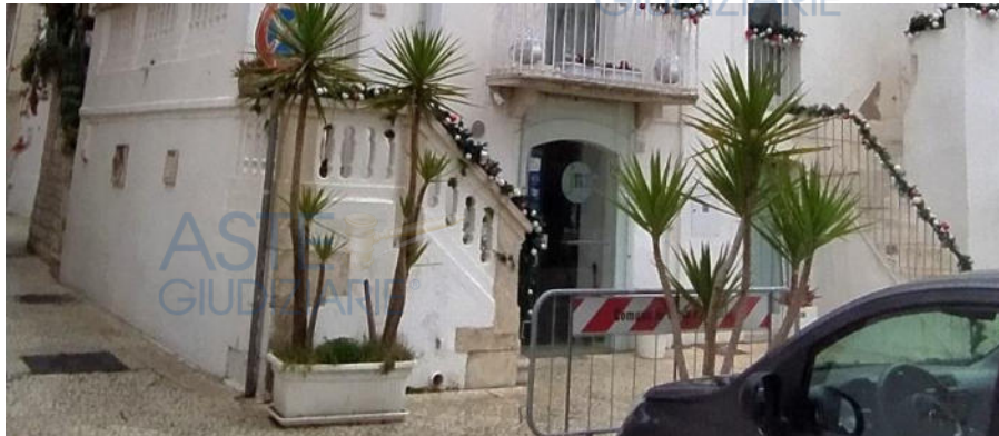
Accesso all'immobile dalla via Petrerà 18
