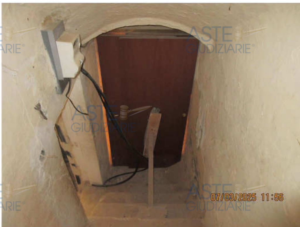
Foto n.18 Porta adiacente al portoncino metallico per accesso dal civico n. 28
