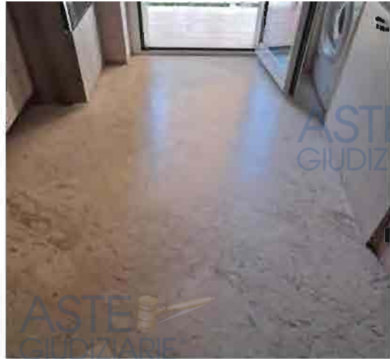
Foto n. 11: Pavimentazione Cucina - Pranzo
