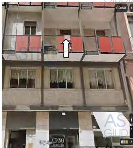
Facciata unità immobiliare esecutata
