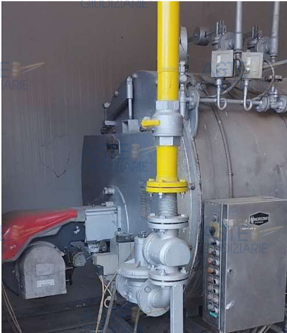
Foto 92- Impianto termico C.T. n.1
