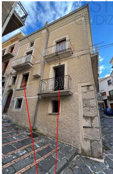
piano terra: lato Via Carpine
