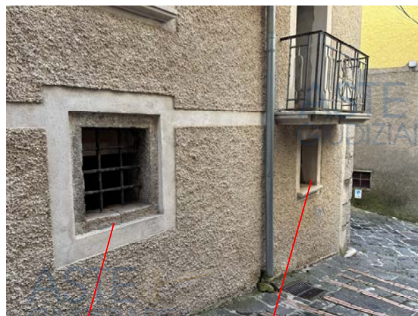
finestre piano seminterrato
