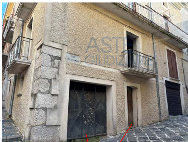
ingresso piano seminterrato
