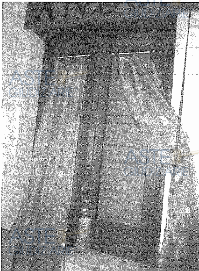
Foto n. 23 <WC zona notte - In evidenza tipologia di infissi esterni in legno con tapparelle in pvc - All. N. 3>
