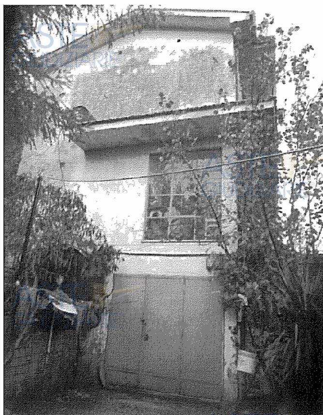
Foto n.10 <Prospetto OVEST – Ingresso piano Seminterrato - All. N. 3>
