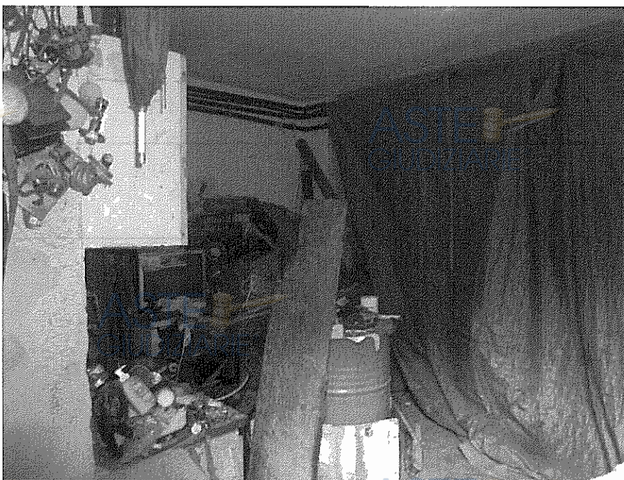
Foto n. 28 <Deposito pertinenze agricole - garage - All. N. 3>
