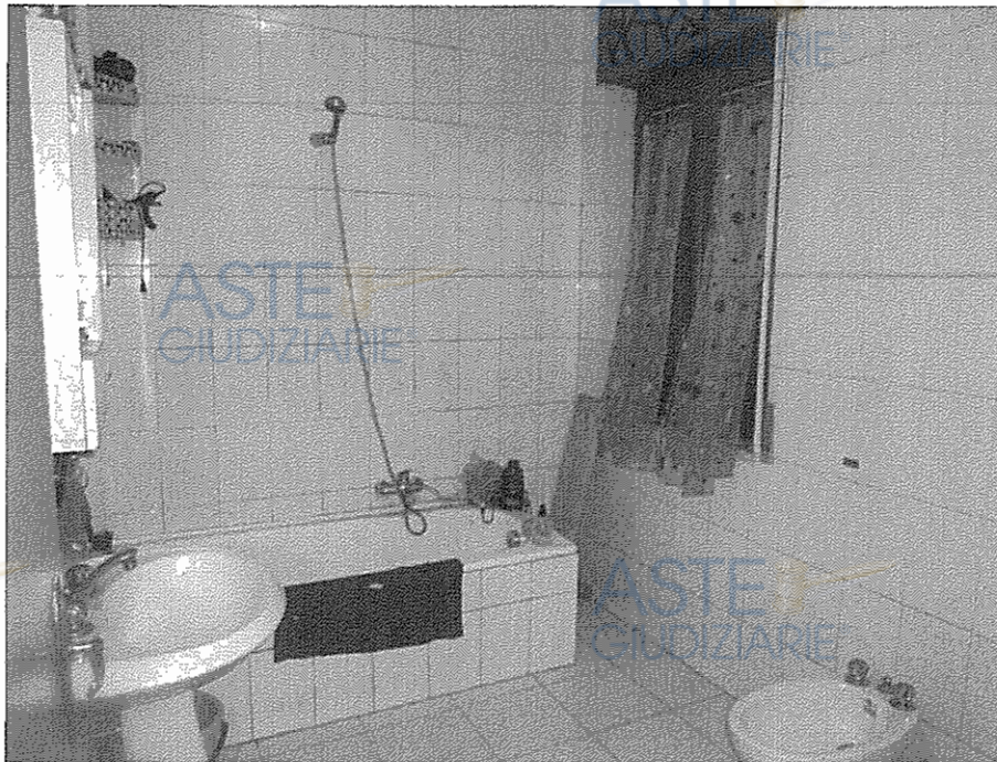
Foto n. 23 <WC zona notte - All. N. 3>
