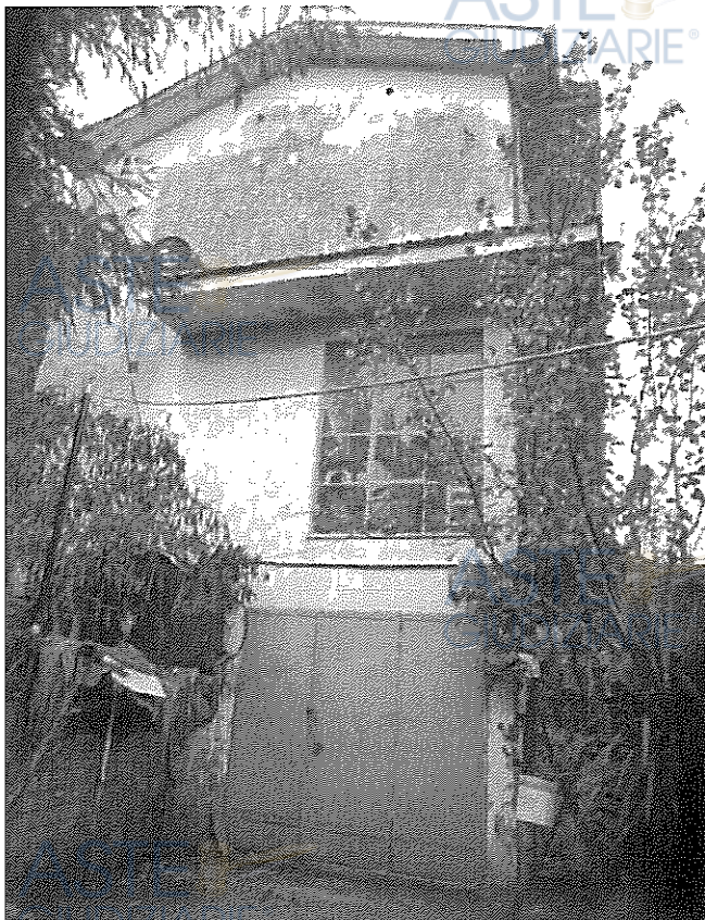
Foto n.10 <Prospetto OVEST – Ingresso piano Seminterrato - All. N. 3>
