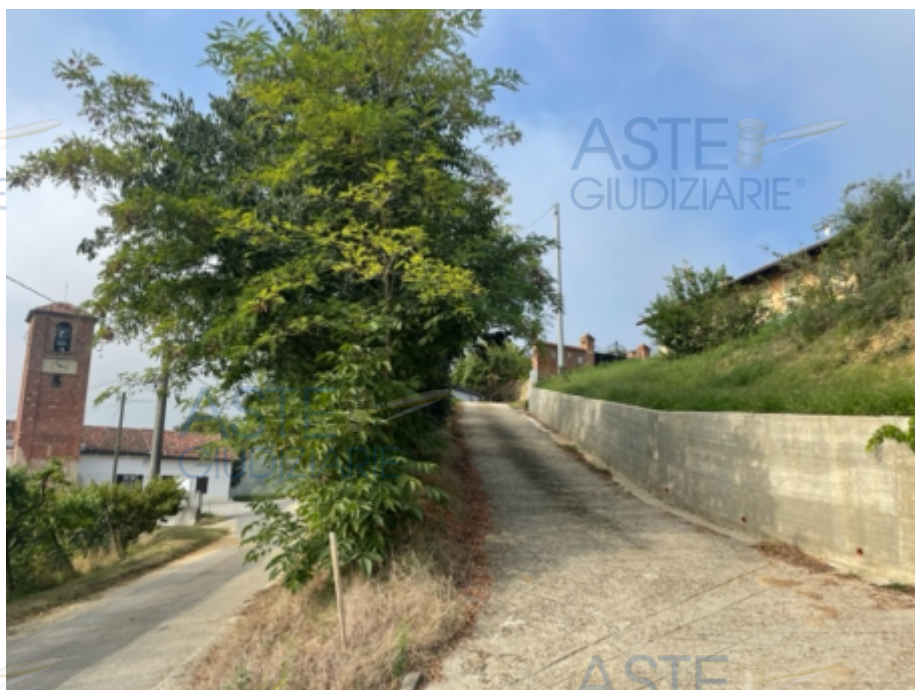
Part.IIa n. 1179 – Scarpata e rampa di accesso
