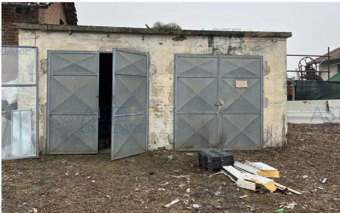
Vista della facciata ovest con i doppi portoni di ingresso
