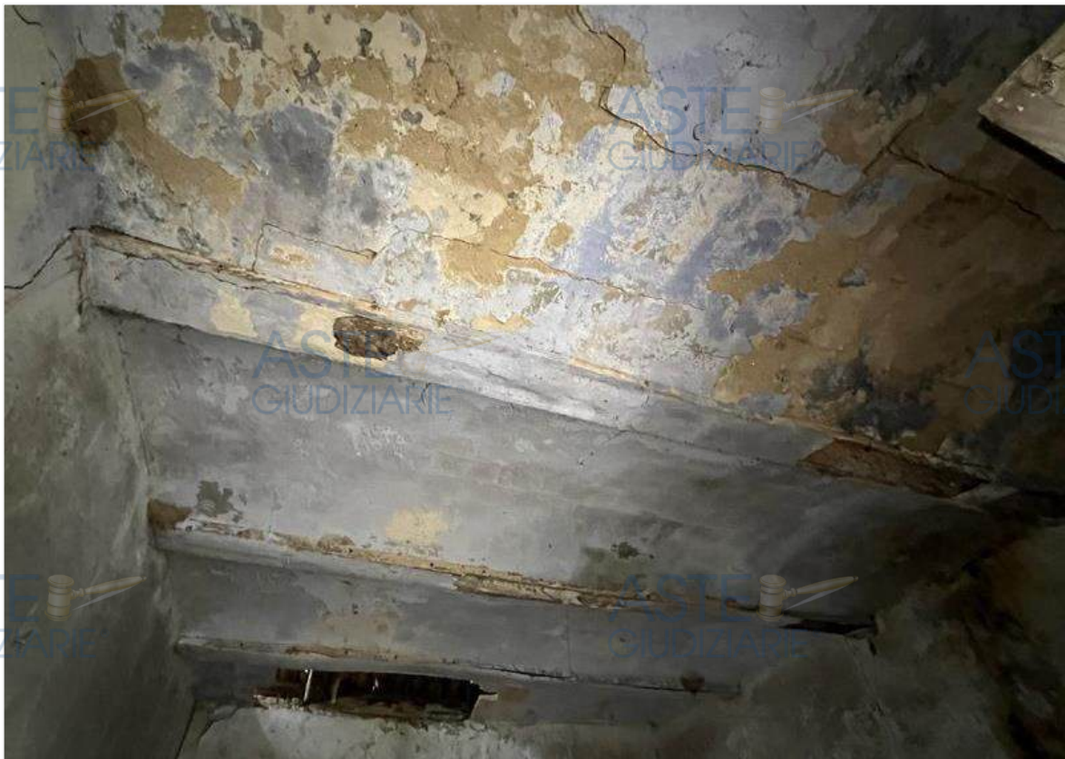
Viste del pessimo stato di conservazione del soffitto, in alcuni punti mancante, con conseguente vista del tetto
