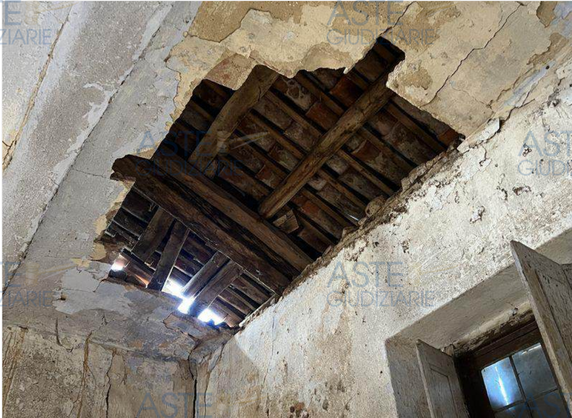
Viste del pessimo stato di conservazione del soffitto, in alcuni punti mancante, con conseguente vista del tetto
