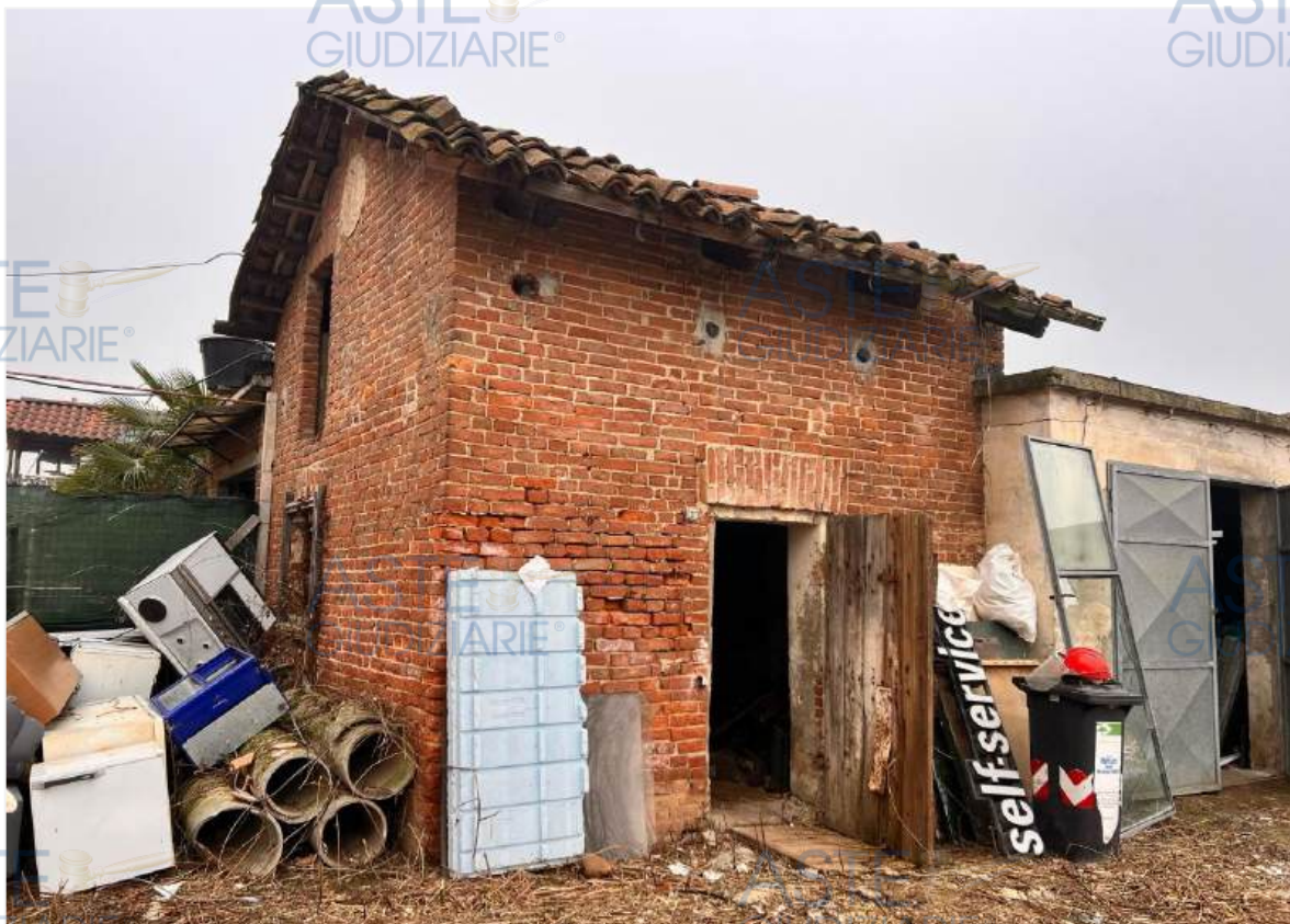
Vista del prospetto ovest dove si trova la porta di ingresso al piano terra
