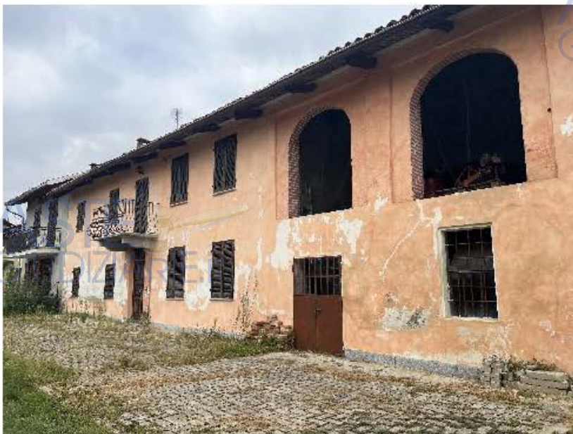
Prospetto Sud-Est- Foto da cortile interno
