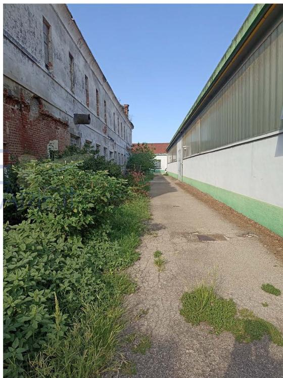
L'immobile, alla data del sopralluogo, risulta allo stato grezzo, abbandonato, con evidenti parti pericolanti, soprattutto parte del piano primo. Mentre una parte risulta ristrutturata nel 2011 a causa delle innumerevoli infiltrazioni che creavano dei danni al proprietario sottostante.
