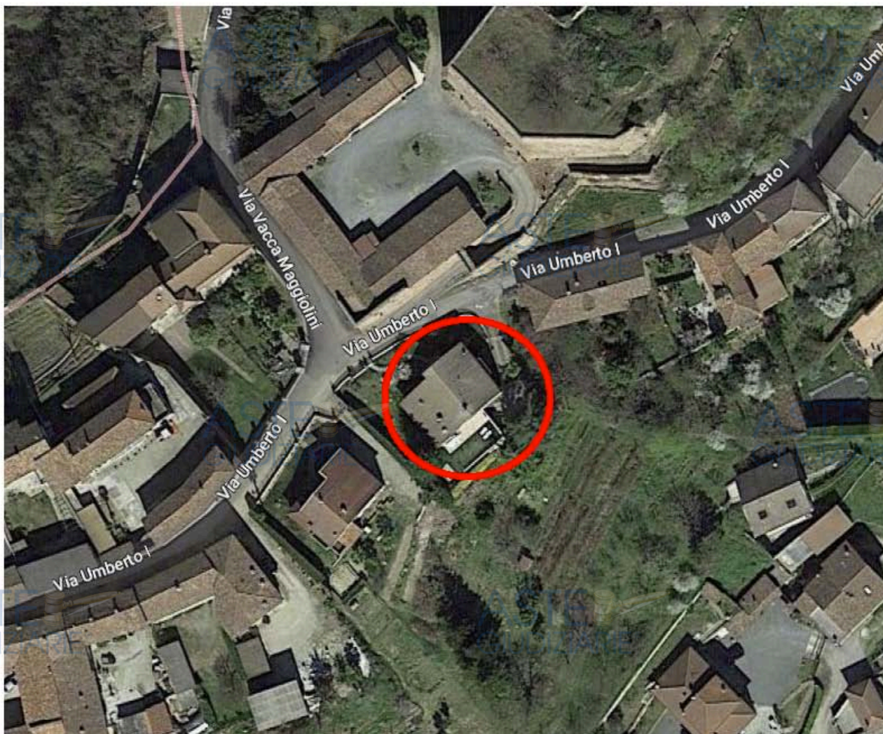
Vista satellitare ubicazione immobile
