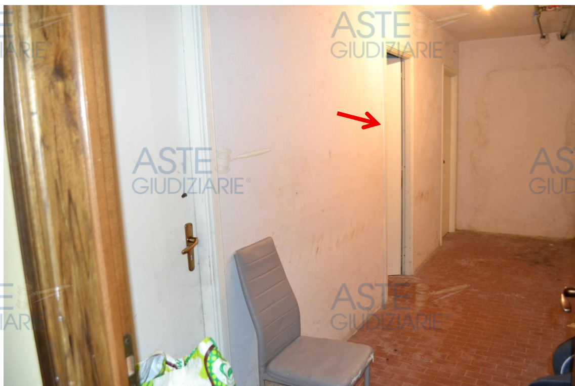
Foto 5: Vista del corridoio cantine con indicazione della cantina rilevata sul posto
