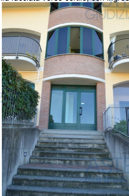
Foto 8: Vista dell'ingresso del condominio
