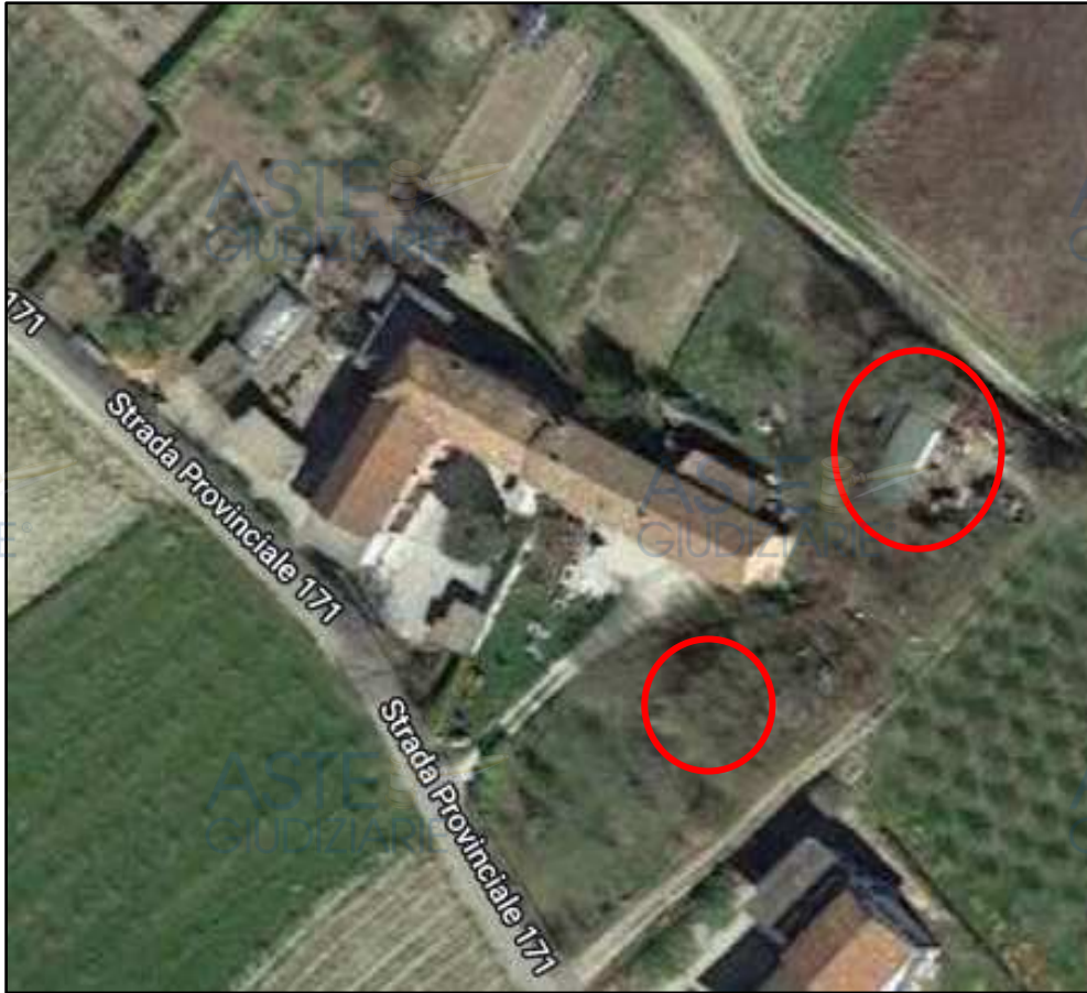
Immagine satellitare con indicazione tettoie esistenti
