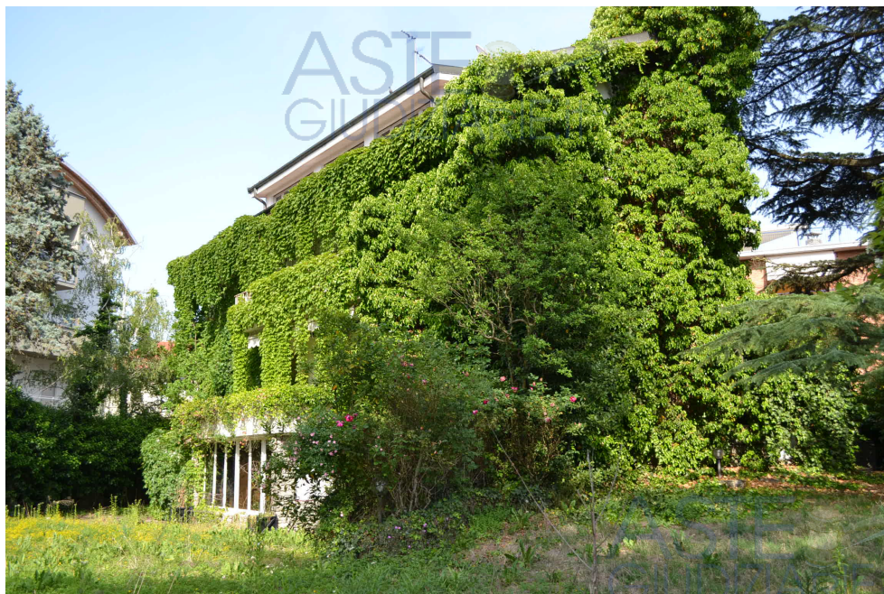
Foto 4: Il fabbricato invisibile per quanto concerne i prospetti per la vegetazione presente
