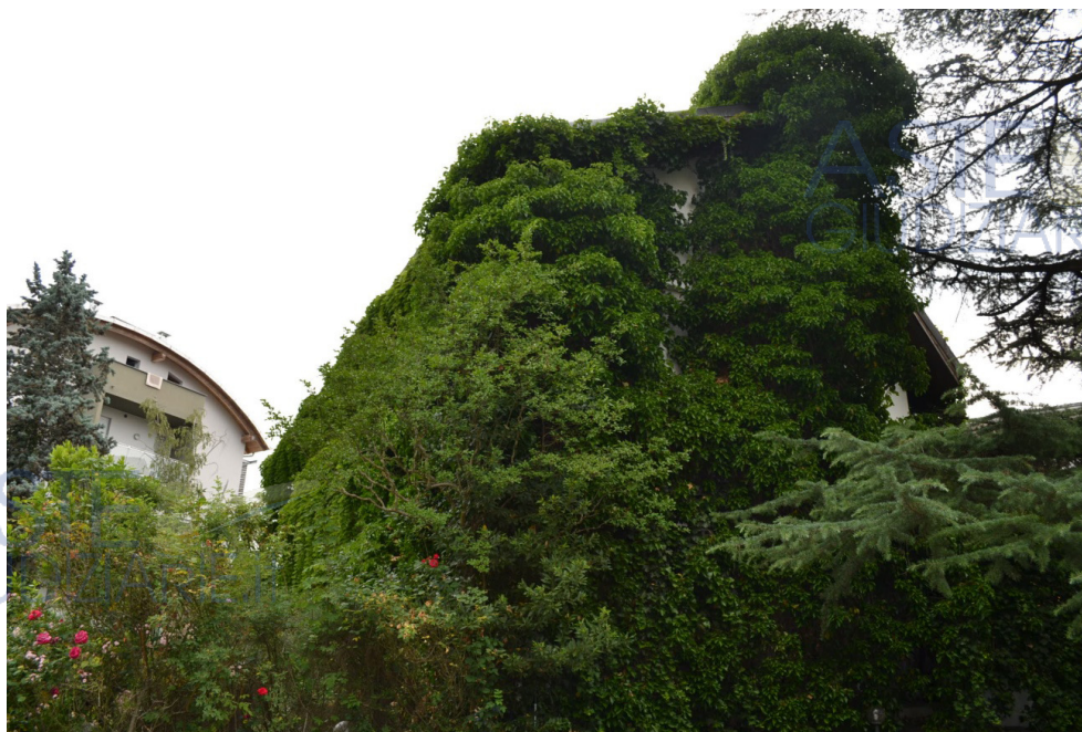
Foto 5: Vista del fabbricato dal cortile completamente occultato dalla vegetazione
