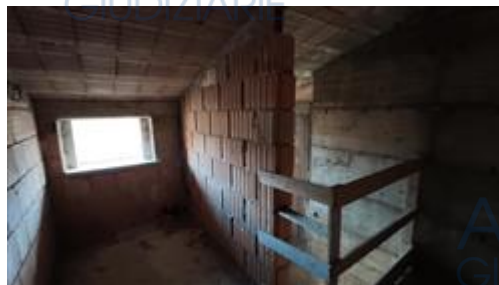
A8 - Lavanderia soffitta
