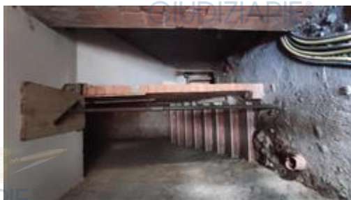
Vano scala a comune
