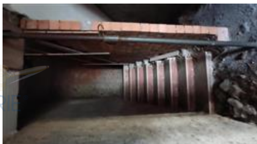
Prima rampa vano scala a comune
