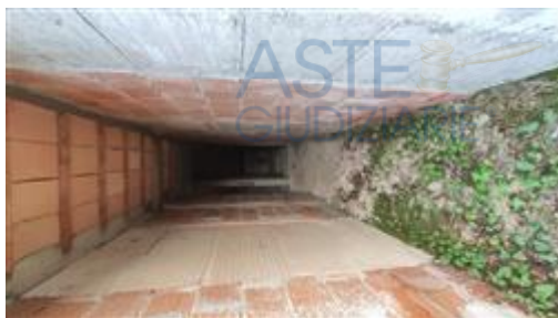
Corridoio di accesso a comune
