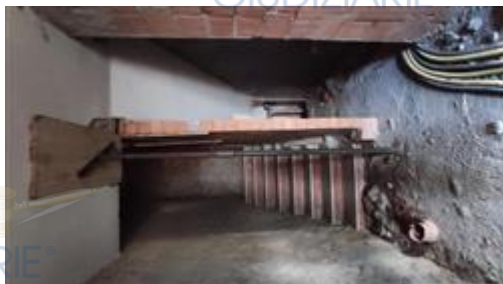
Vano scala a comune
