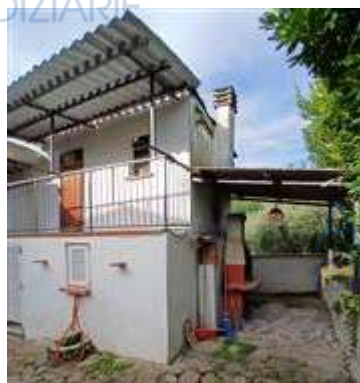
Prospetto laterale destro
