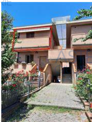
Vista da accesso retro
