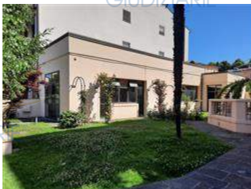
Vista da resede interno
