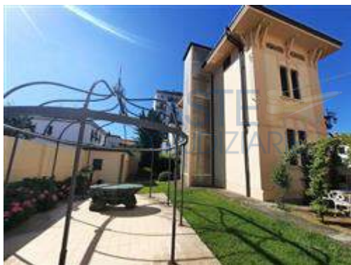
Vista esterna villetta
