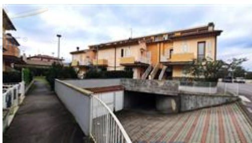
Rampa condominiale di accesso al piano interrato
