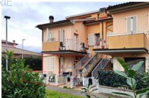
Vista dal vialetto condominiale del prospetto principale
