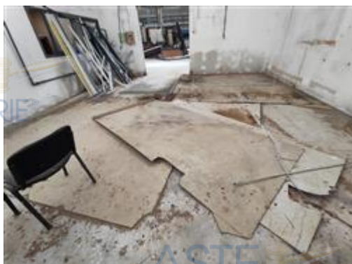
Plafonature e pareti in cartongesso a terra
