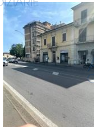
il fabbricato in oggetto posizionato sul fronte stradale del Lungarno
