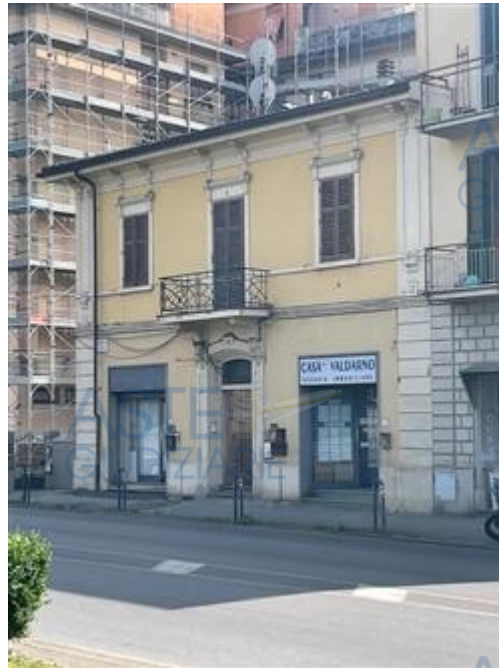
vista su ingresso esterno dalla strada (sporto a destra)
