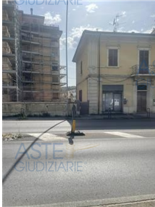
vista su ingresso esterno dalla strada
