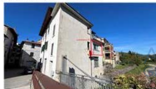
prospetto laterale destro - lato fiume
