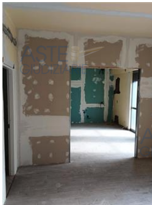
Ingresso Cucina - appartamento 1
