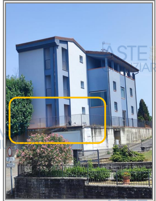
Vista laterale destra del fabbricato
