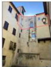
vista dalla corte di Palazzo Martini
