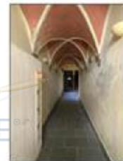
vista dall'androne d'ingresso condominiale
