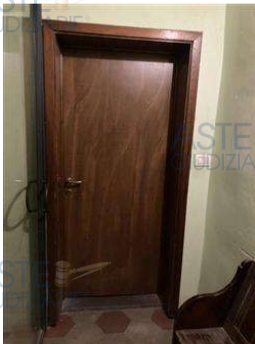
ACCESSO A UFFICIO LATO SINISTRO
