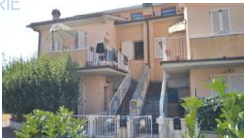
vista frontale, fabbricato 3
