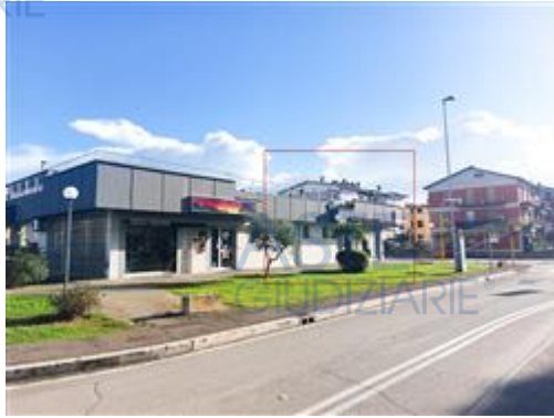
Scorcio del fabbricato da Via Antonio Stoppani
