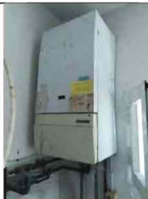
Impianto di riscaldamento piscine con caldaia a gas autonomo. Contatore Gas non autonomo.
