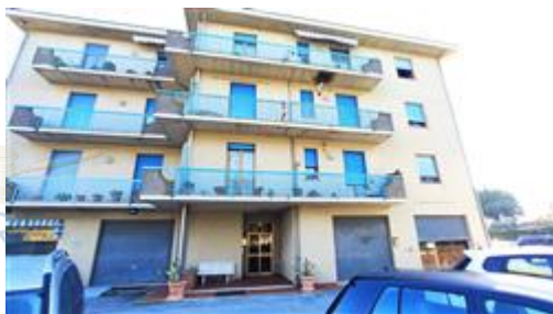
Prospetto principale del fabbricato
