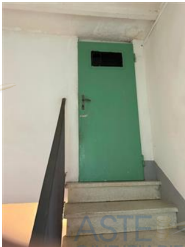
Vista ripostiglio esterno -1
