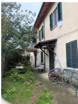
Vista tergale edificio
