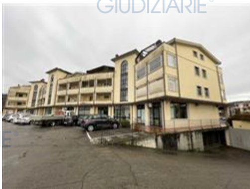
VISTA DEL FABBRICATO CON LA RAMPA DI ACCESSO AL PIANO INTERRATO
