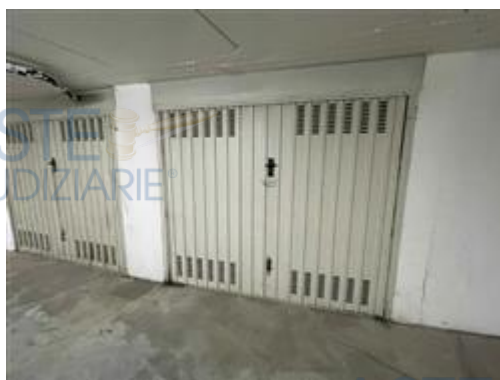
VISTA DELLA BASCULANTE DEL BOX
