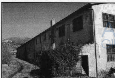
Foto: 05 Data ripresa: 14/02/2006 Edificio: 168 File: 168-05.JPG
