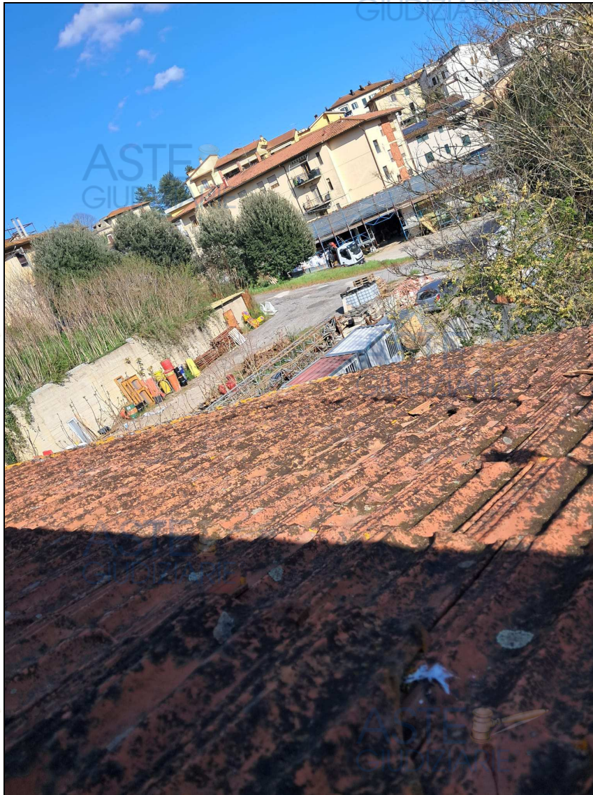
Foto 2 – foto manto di copertura
