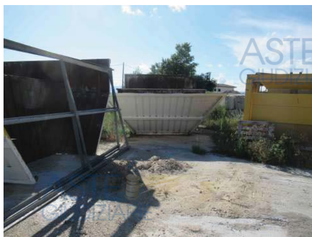
Foto 18 - Impianto di calcestruzzo - vasche
