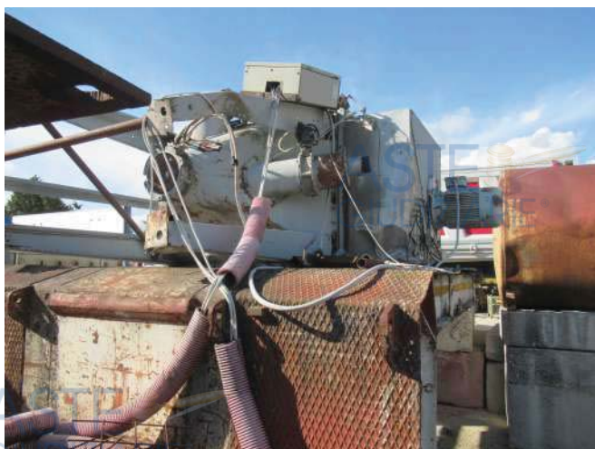
Foto 21 – Impianto di calcestruzzo - Tramoggia
