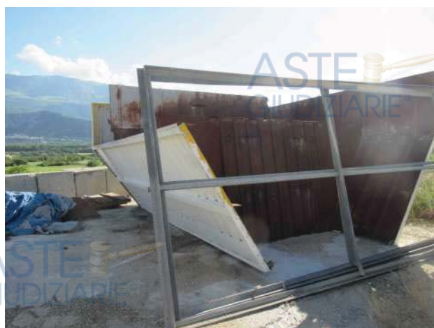
Foto 17 – Impianto di calcestruzzo- vasche
