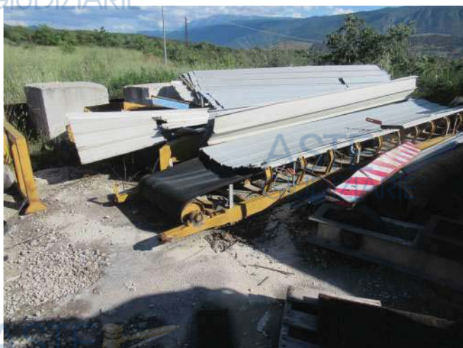
Foto 19 – Impianto di calcestruzzo- nastri trasportatori
