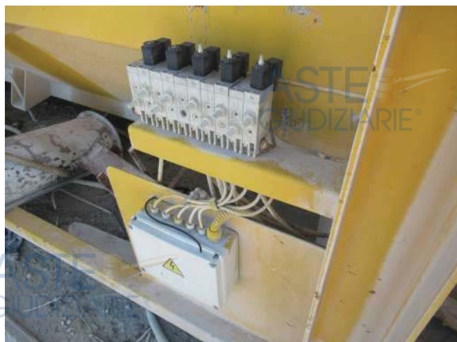
Foto 15 – Impianto di calcestruzzo
