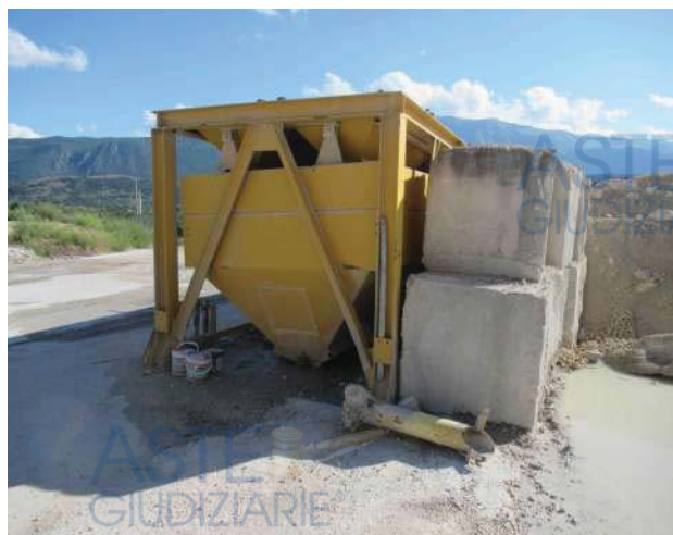
Foto 14 – Impianto di calcestruzzo
