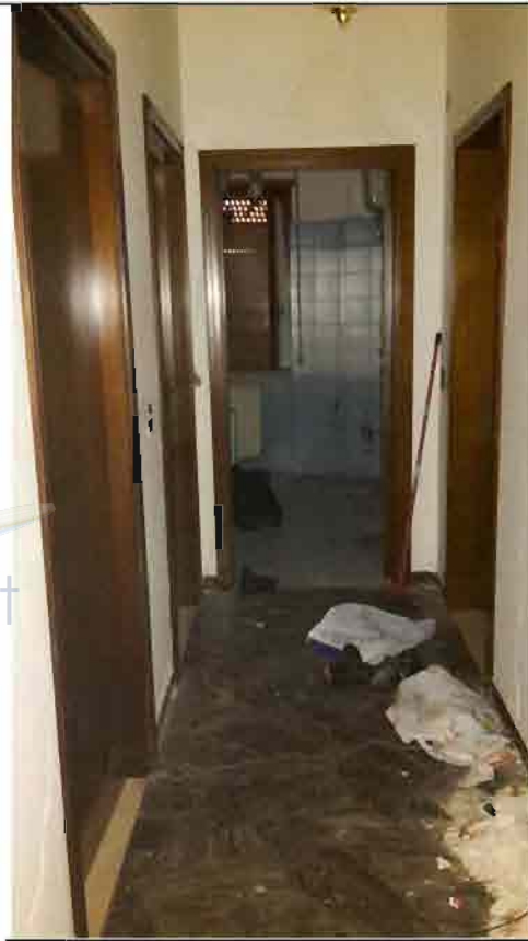
Corridoio verso wc
