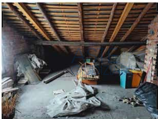
Foto 17 – Sottotetto vista sud
