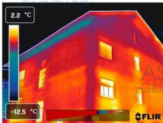
Foto 20 – Termografia nord-ovest edificio
