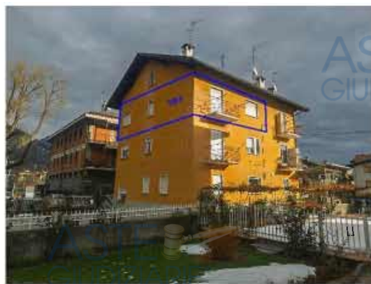
Foto 2 - Vista sud-ovest edificio
