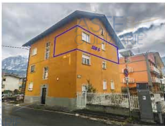
Foto 1 - Vista nord-ovest edificio
