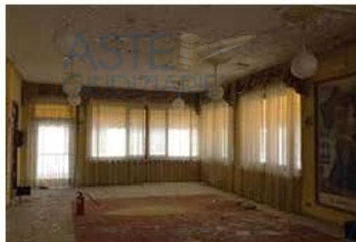
Vista di una porzione della sala ristorante in cui si evidenziano diffuse esfoliazioni dello strato corticale interno dell'intradosso del soffitto superiore.
