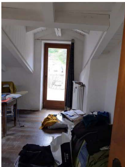
FOTO 9 – RIPRESA FOTOGRAFICA EFFETTUATA DAL C.T.U. - piano secondo sottotetto
