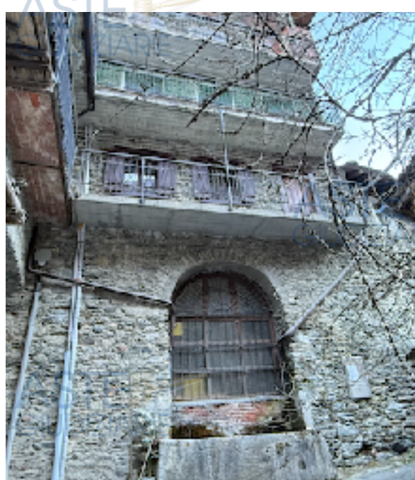
Facciata lato est
