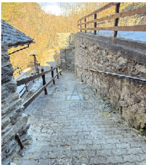
Rampa di accesso su particella 383
