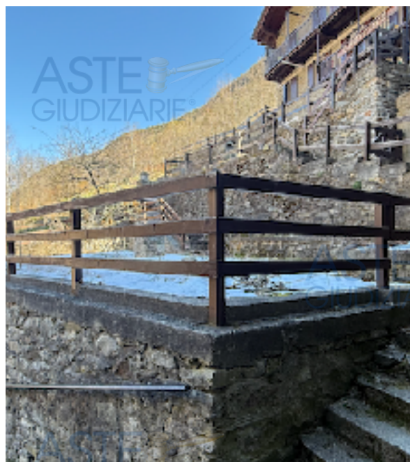
Area su particella 199
