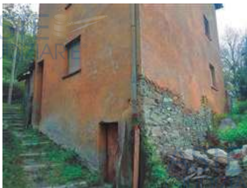
VISTA DA OVEST
