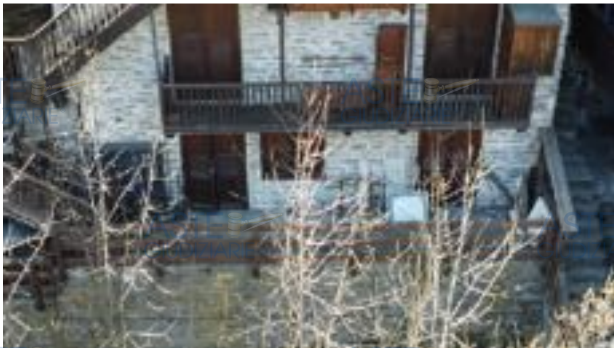
FACCIATA LATO NORD
