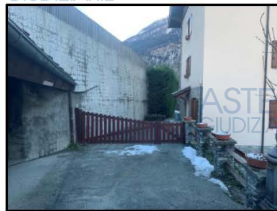
Particolare ingresso area di proprietà
