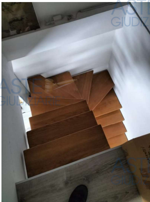
RIPRESA FOTOGRAFICA 10 EFFETTUATA DAL C.T.U. – SCALA DI COLLEGAMENTO PIANO PRIMO
